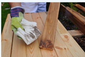
Po 15 minútach nevsiaknutú lazúru zotrieme
