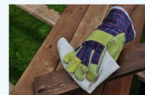
Nevsiaknutú lazúru zotrieme po 15 minútach po nanosení každej vrstvy
