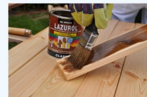
Nanášame štetcom v 2 vrstvách v intervale 24 hod.
